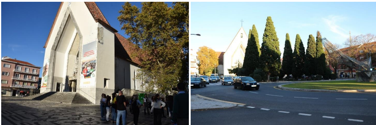
Figure 24. São João de Brito Church
